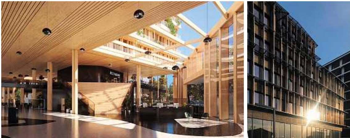
L'Arboretum (à gauche), à Nanterre, prévu pour 2022, et Perspective (à droite), à Bordeaux, livré à l'été 2018, deux immeubles de bureaux à la structure en bois massif.
