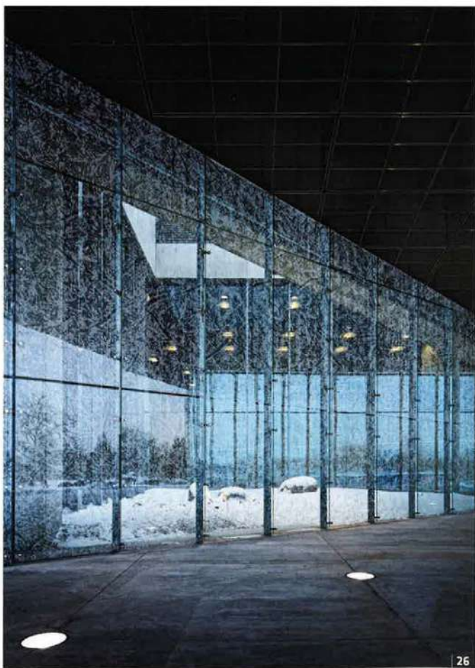
26 | Elewację wykonano z tafli o wymiarach 1,5 x 3 m ze szkła laminowanego pokrytego sitodrukiem. Aby nadać jej wrażenie lekkości, szyby mocowano do smukłej konstrukcji wsporczej
