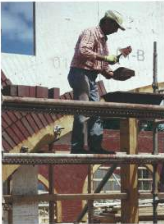
Les arches sont constituées d'une double rangée de briques de terre cuite locales. Elles sont hautes de 7 m pour une portée maximale de 9 m.
