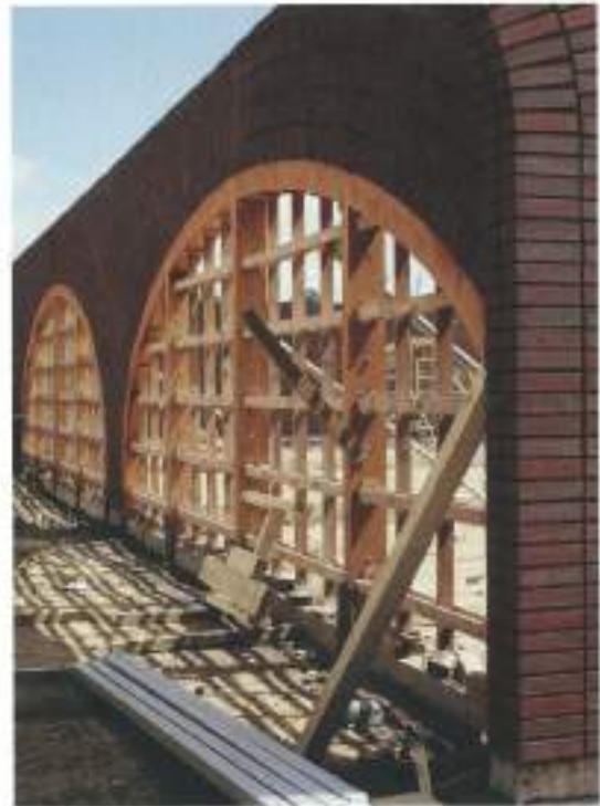
Les arches sont constituées d'une double rangée de briques de terre cuite locales. Elles sont hautes de 7 m pour une portée maximale de 9 m.
