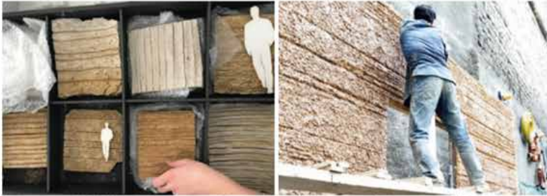
左/スクラッチの模様を検討するためたくさんのサンプルをつくったが、手作業となればサンプル通りはいかない。「結局、重要なのはスクラッチをつくる脚をデザインすることだったんです」とゴットメさん。右/手作業だから一気に全体を仕上げることは不可能だ。恐ろしく手間と時間のかかる方法だが、だからこそ地元の人と彼らが暮らす街に建築がしっかりと根づいていく。2点写真:LGA
