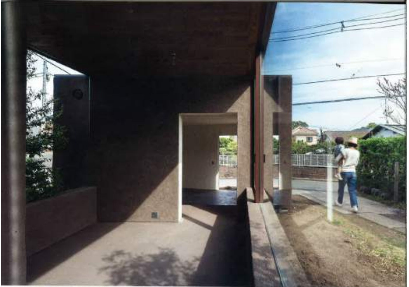
玄関から居室方向を見渡す。外部よりも取り込まれた玄関の床下には地中蓄熱式床暖房を設置。
