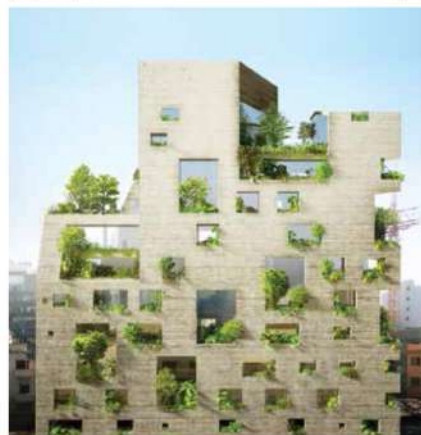
Stone Gardens situé dans la région du port de Beyrouth.
